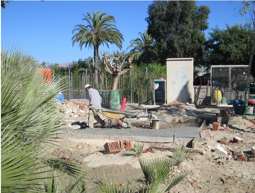
Fotografía nº 9. Instalación de losa de hormigón armado para cubrir las subsidencias del terreno.
