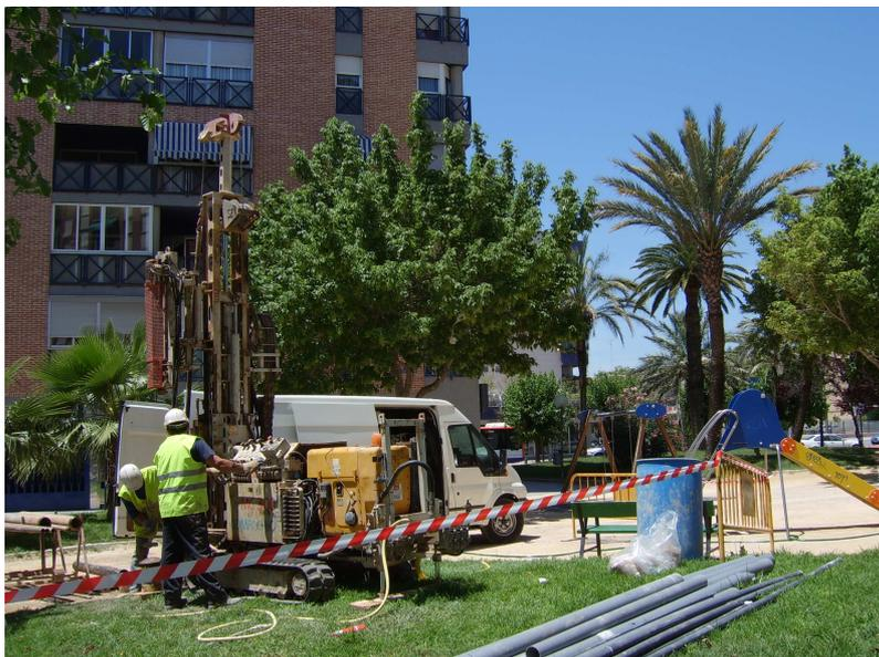
Fotografía nº 1. Imagen que muestra la maquina de perforación ejecutando un piezómetro, junto a la Plaza Castilla
