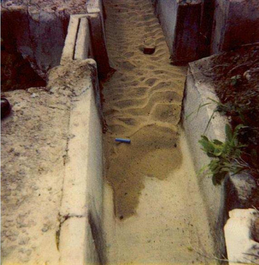
Fotografía nº 10. Ejemplo de arrastre mecánico de sedimentos.
