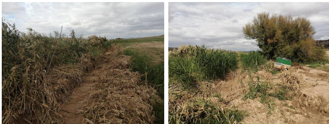
Foto 3.5. Canal de la Fuente de Las Tres Gotas, totalmente colmatado. MSBT 070.007
