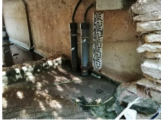
Escala y detalle del registro continuo instalado
