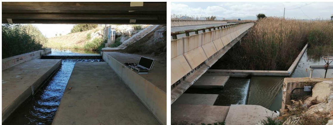
Foto 3.25. Sección de aforo en la desembocadura de la Rambla del Albujón en el Mar Menor.
