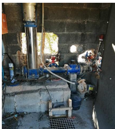
Foto 121. Fuente de La Mina. Caseta de distribución y bomba de reparto
