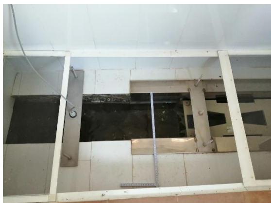
Toma para abastecimiento instalada con un canal Parshall
