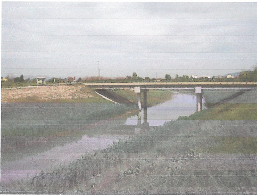
Puente del Rincón de Beniscornia. Río Segura. (Ramón Plano. Panoramio.com)
