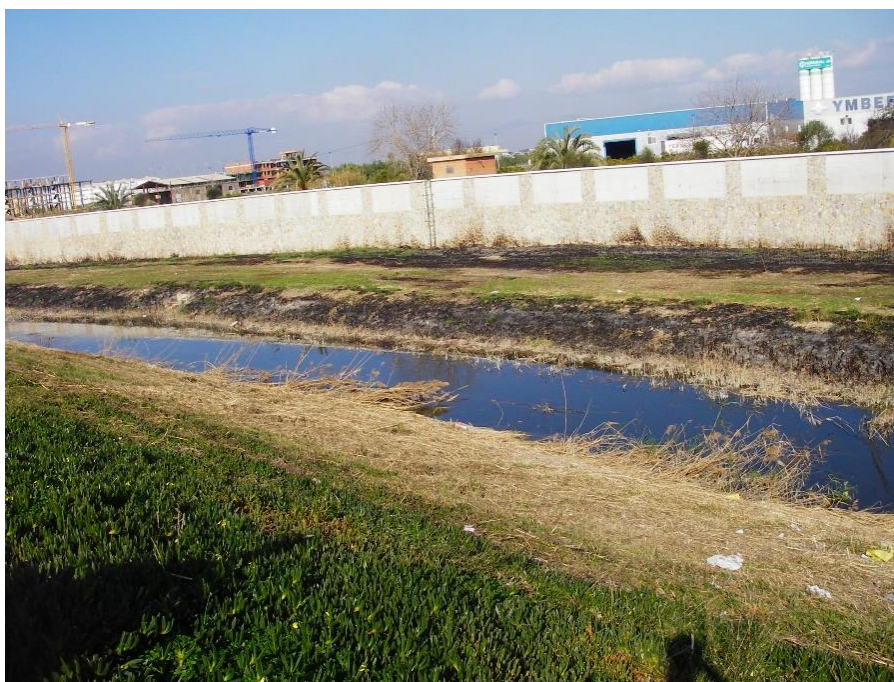
Figura 7. Canalización trapezoidal realizada en tierra donde se intercalan tramos con obra de fábrica y mampostería. Río Segura en Rojales. Fuente: Comisaría de Aguas de la CHS.
