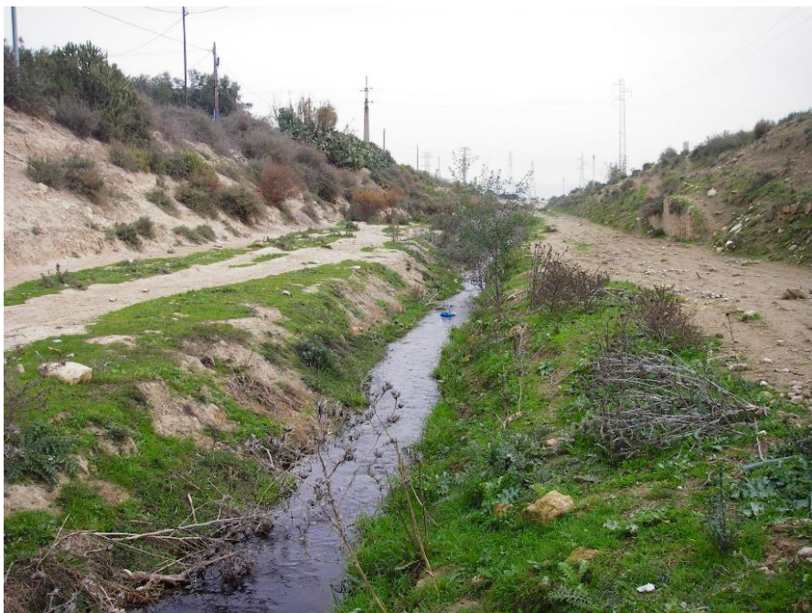
Figura 6. Encauzamiento del Reguerón. Fuente: Comisaría de Aguas de la CHS.
