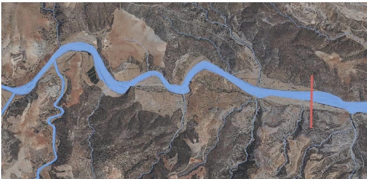
Vista aérea actual de la zona que ocuparía el embalse. Se observa la escasa vegetación existente
