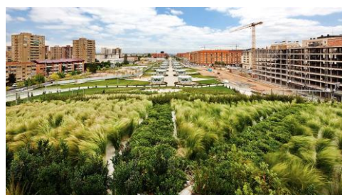
Estación de Ferrocarril y Autobuses de Logroño. Fuente: MITECO (cortesía de SUDS SL - Atlantis)
