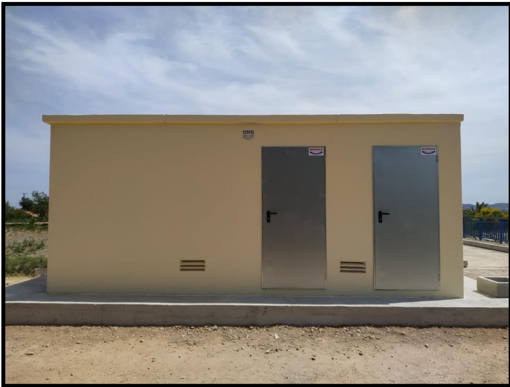
Foto 1. Exterior de la nueva estación de Los Huertos.
