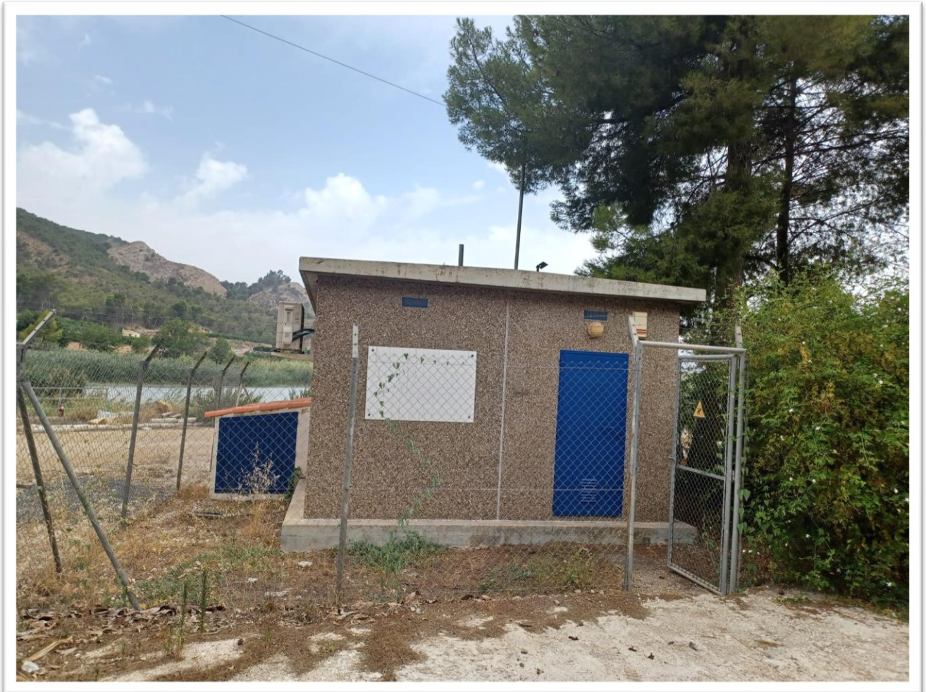
Foto 1. Exterior de la EAA de Ojós.
