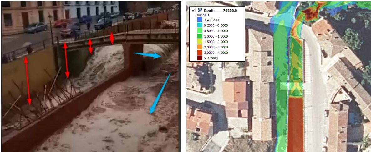
Imagen 1. Encauzamiento del arroyo de Letur. Situación en la pasarela (derecha) y calado máximo alcanzado en la primera punta (izquierda). Modelo de bidimensional revisado, avenida de la tarde del 29 de octubre de 2024. Fuente: elaboración propia
